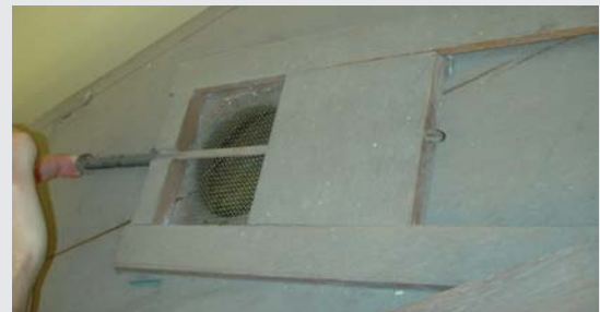
Part superior de l'entaulament, que inclou el mecanisme de molles que permet l'obertura i la ventilació de l'interior.
