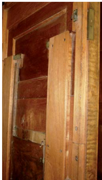
A dalt, enginy d'obertura de l'interior del cos inferior. Les fonadures inclouen una reixeta d'aireig i un mecanisme d'anella i molles per aixecar-la.
