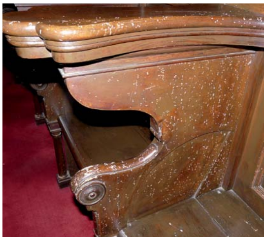
Algunes zones del cadiratge del cor tenien un greu i massiu atac de xilòfags. A la dreta, aspecte de l'erosió característica del recorregut de la banqueta abatible.
