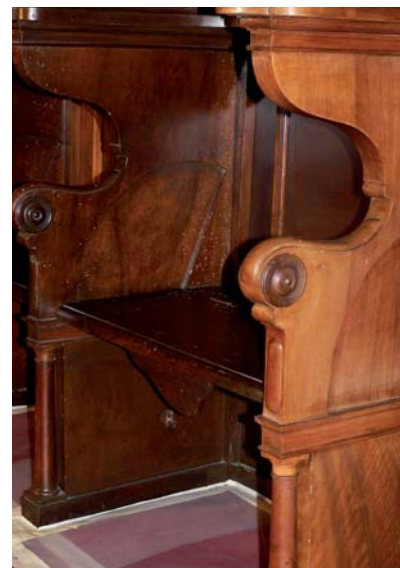
Algunes zones del cadiratge del cor tenien un greu i massiu atac de xilòfags. A la dreta, aspecte de l'erosió característica del recorregut de la banqueta abatible.
