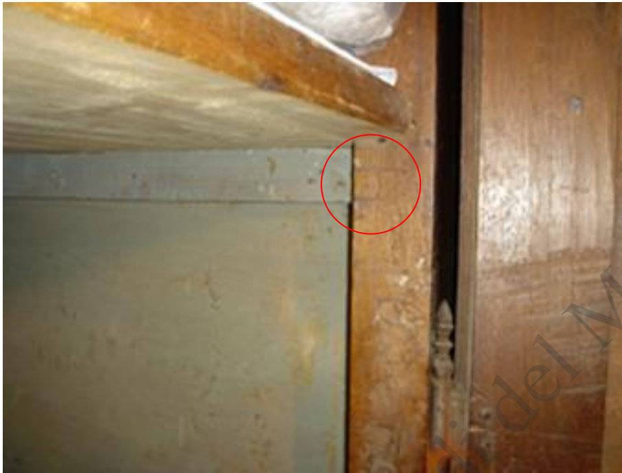
Figura 19. Marca en creu al muntant pret del bastidor de l'armari, sota la lleixa tercera.
